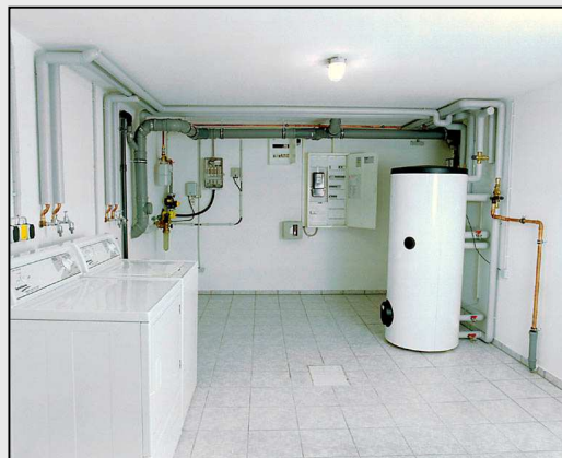
Komplette Fliesung des Kellerbodens, perfekte Installation
