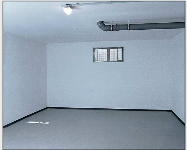
Kellerinnenraum in wasser- und durchlässiger Betonkonstruktion
